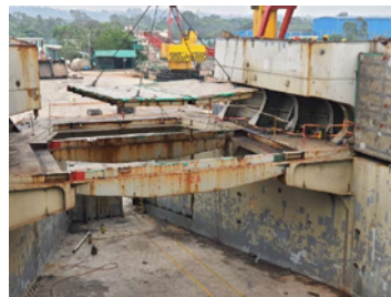
船舶の解体風景（内側からの様子）
