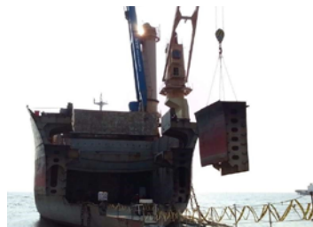
船舶の解体風景（船首側からの様子）
