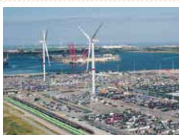
ゼーブルージュ港の完成車ターミナルに設置された風力発電設備
