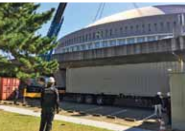
コンテナ型の設備を会場の駐車場に据え付け
