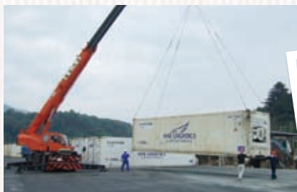
港からトラックで運ばれたコンテナをクレーンで設置 (女川町)
