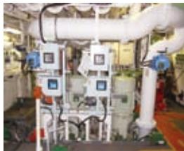
エンジンルーム内に設置された装置の構成機器。海水のバイパスラインと制御ユニットが見える
