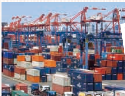
大井コンテナターミナルのコンテナヤード
