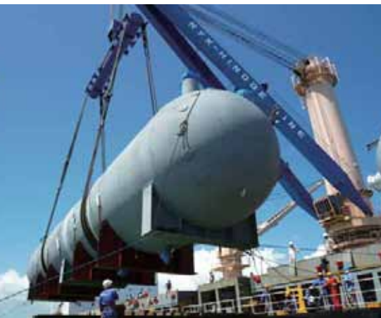
巨大なプラント機器の荷役。現場に緊張感が走る
