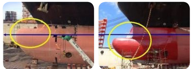
▲ 改造前 ▲ 改造後 バルバスパウの改造（船型や運航条件に併せてバルバスパウの形を改造）
